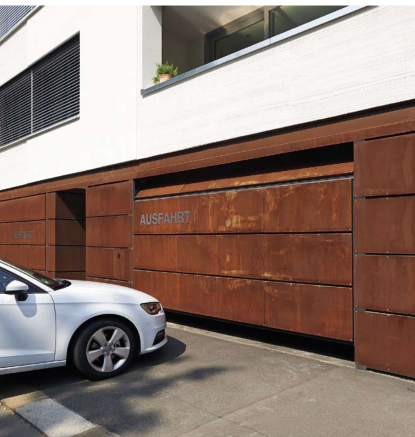
Brama ALR F42 zlicowana z fasadą budynku
